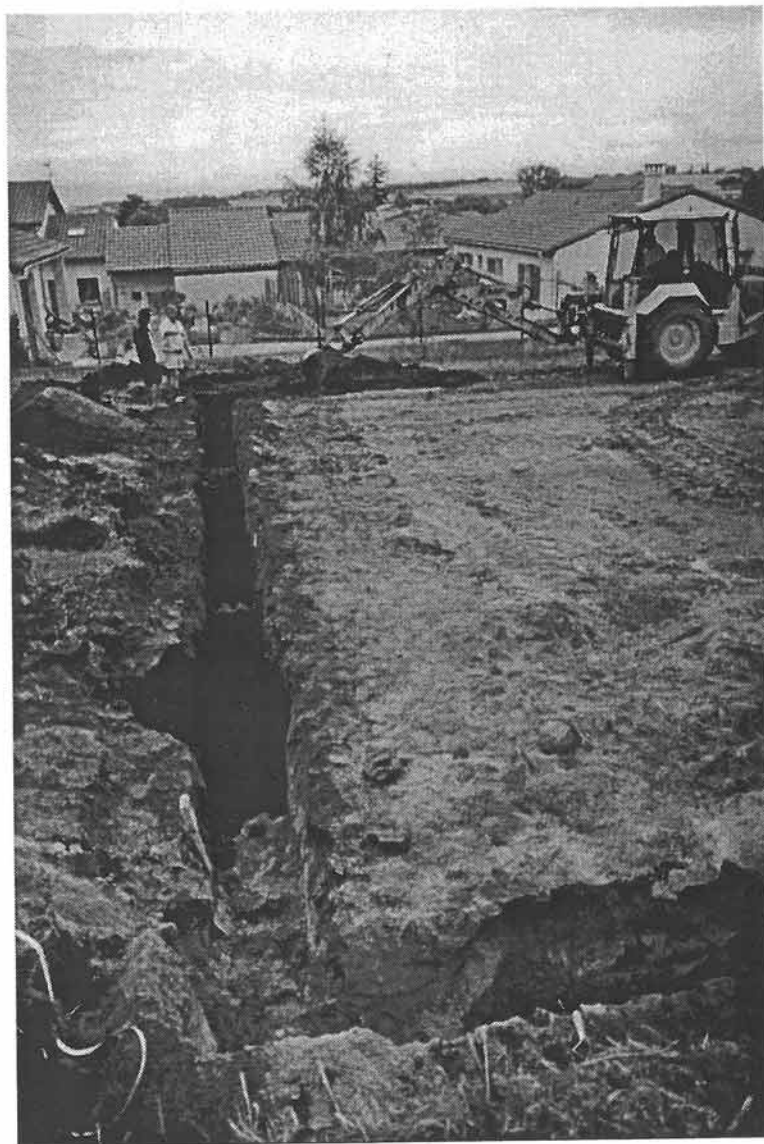
Figure 6 : la tranchée de fondation sud vue de l'est.
