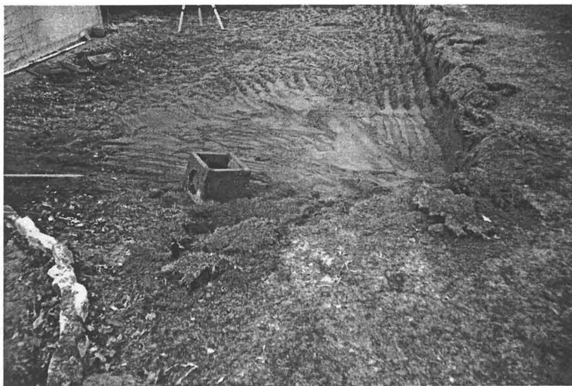
Figure 20 : décaissement de la zone à bâtir du terrain Méjean.
