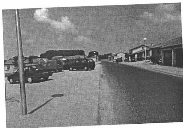
19 : lotissement de l'Enclos, emplacement du grand four vu du nord. 20 : lotissement de l'Enclos, emplacement du grand four vu du sud. 21 : série de poinçons-matrice découverte durant les fouilles de la Z.A.C. de l'Enclos.
