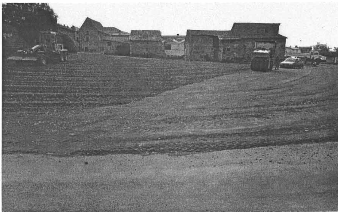
Figure 40 : l'extension du parking de la place lors du compactage du sol au rouleau-compresseur vers le 11 juillet 1995.
