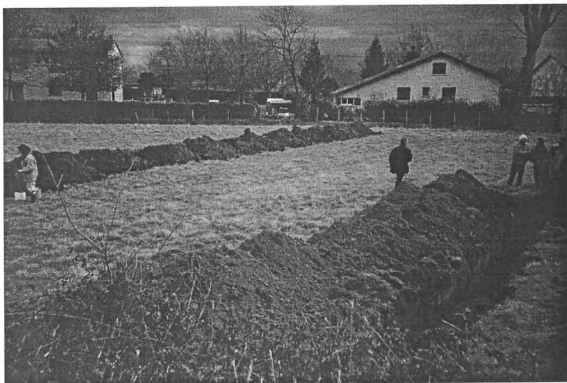
Figure 9 : les tranchées 1 et 2 vues de l'ouest.
